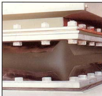
Эластомерные компенсаторы, установленные на газоходах установок газоочистки (проект компании Esmil International, Амстердам) ТЭЦ (600 МВт) в Ниймвегене.
